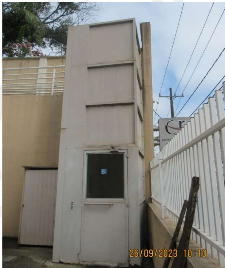
Figura 42 - Plataforma elevatória que será reformada.
