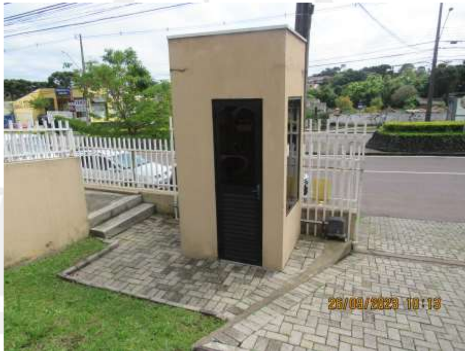
Figura 3 – Guarita que será demolida.
