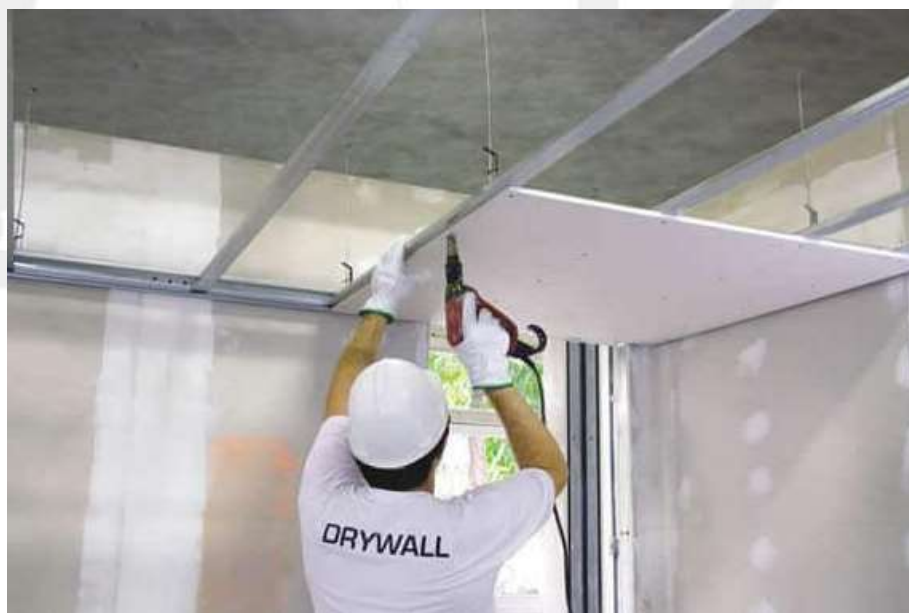
Figura 6 – Exemplo de execução de forro de gesso.
