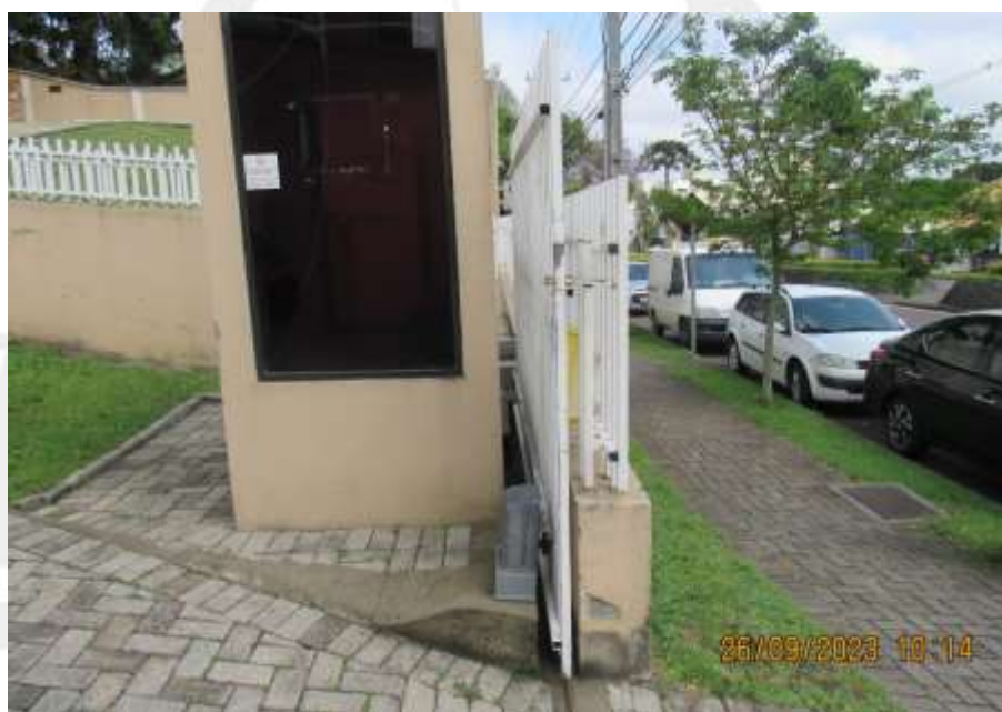
Figura 41 - portão e muro de gradil que será removido.
