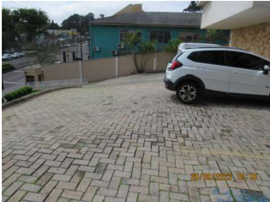
Figura 38 - Demonstração do piso intertravado que será reassentado.
